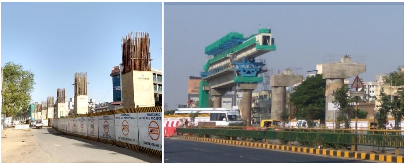
艾哈默德巴德地鐵施工現場
