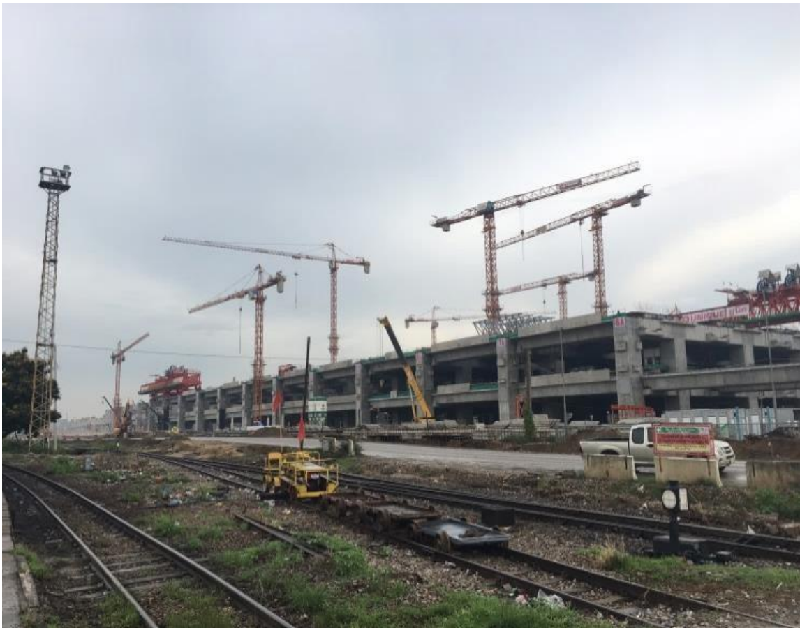
曼谷紅線建設現場
