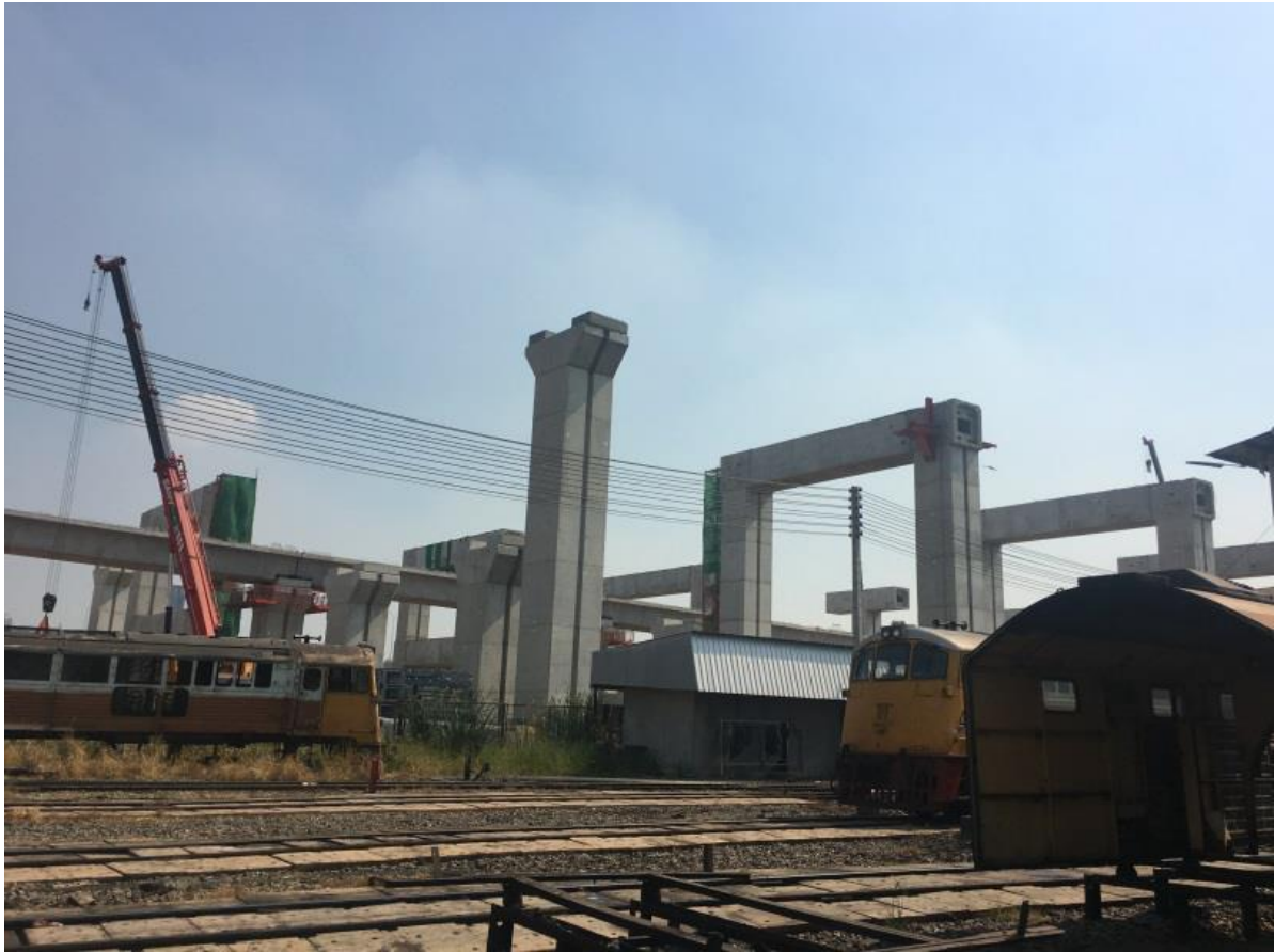
泰國曼谷紅線建設現場
