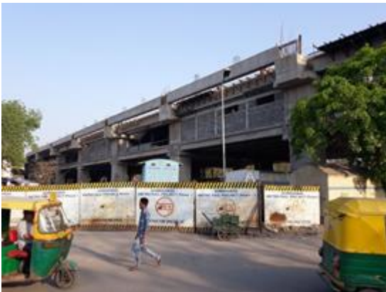
交付 AFC 系統的車站建築工地現場
